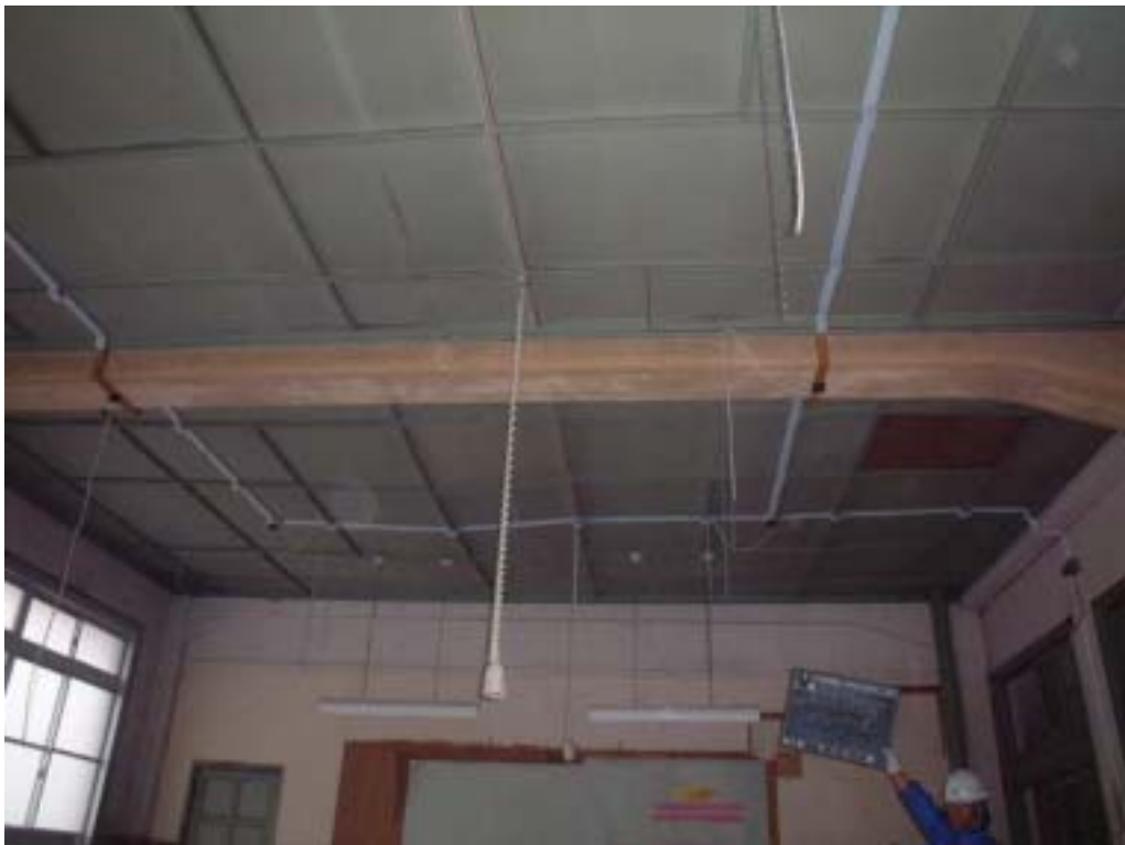
コンピュータ室 天井
