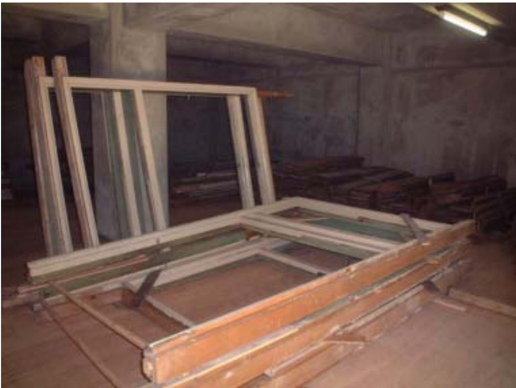
解体材料 保存状況
